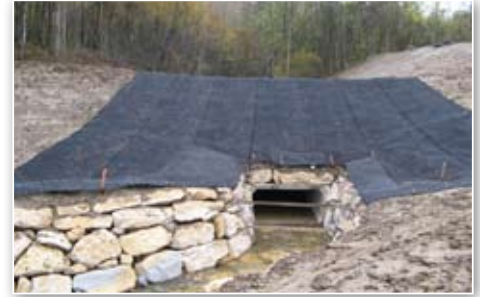
Barrage sur l'Hermance en amont de Veigy
