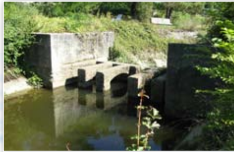
Le secteur amont avant travaux : seuil béton et rivière chenalisée rectiligne
