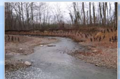
Photo du site amont après travaux et plantations diverses
