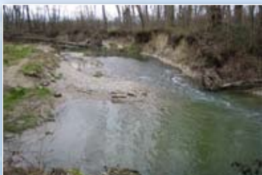
Erosion du secteur amont avant travaux
