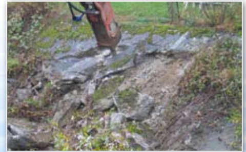
Travaux de démantèlement des berges bétonnées
