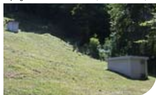
Captage des sources des Moises (S.I.E. des Moises)
