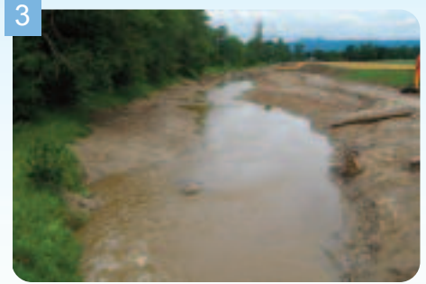
Vue pendant travaux depuis le pont Neuf (en crue)
