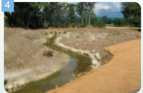
Vue pendant travaux du grand méandre
