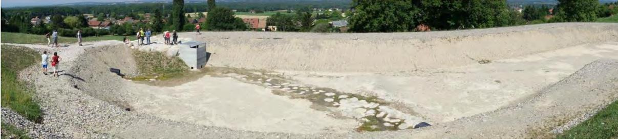
**Bassin de rétention des Mogets (capacité : 2 300 m<sup>3</sup> ; emprise au sol : 4 600 m<sup>2</sup>)**
